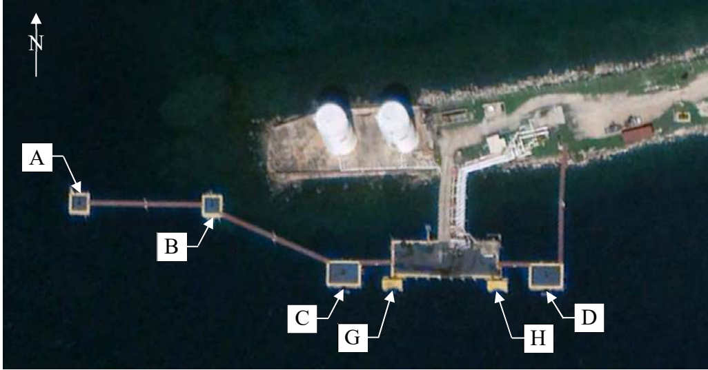
Figure 2 – Pier F1 Overview
